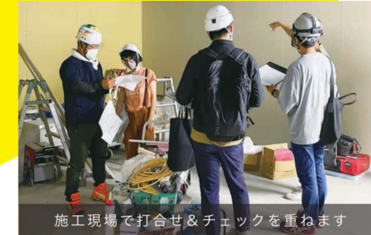
施工現場で打合せ＆チェックを重ねます
