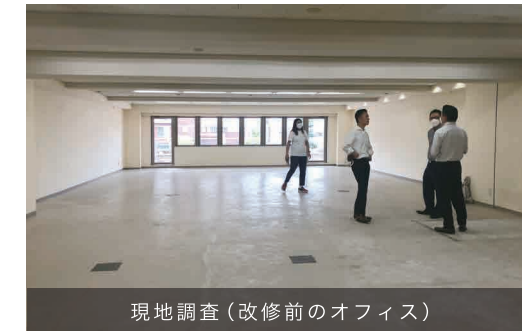
現地調査(改修前のオフィス)
