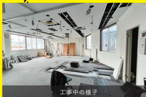
工事中の様子
